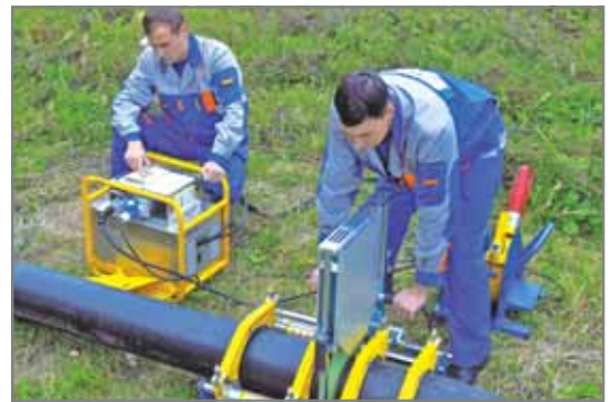
Рис. 2. Сварка встык полиэтиленовой трубы
